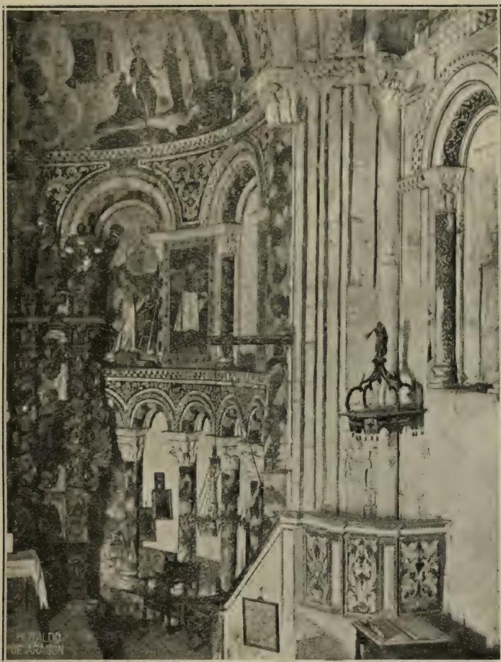
Interior de la iglesia: vista parcial del presbiterio (antes de las obras)
